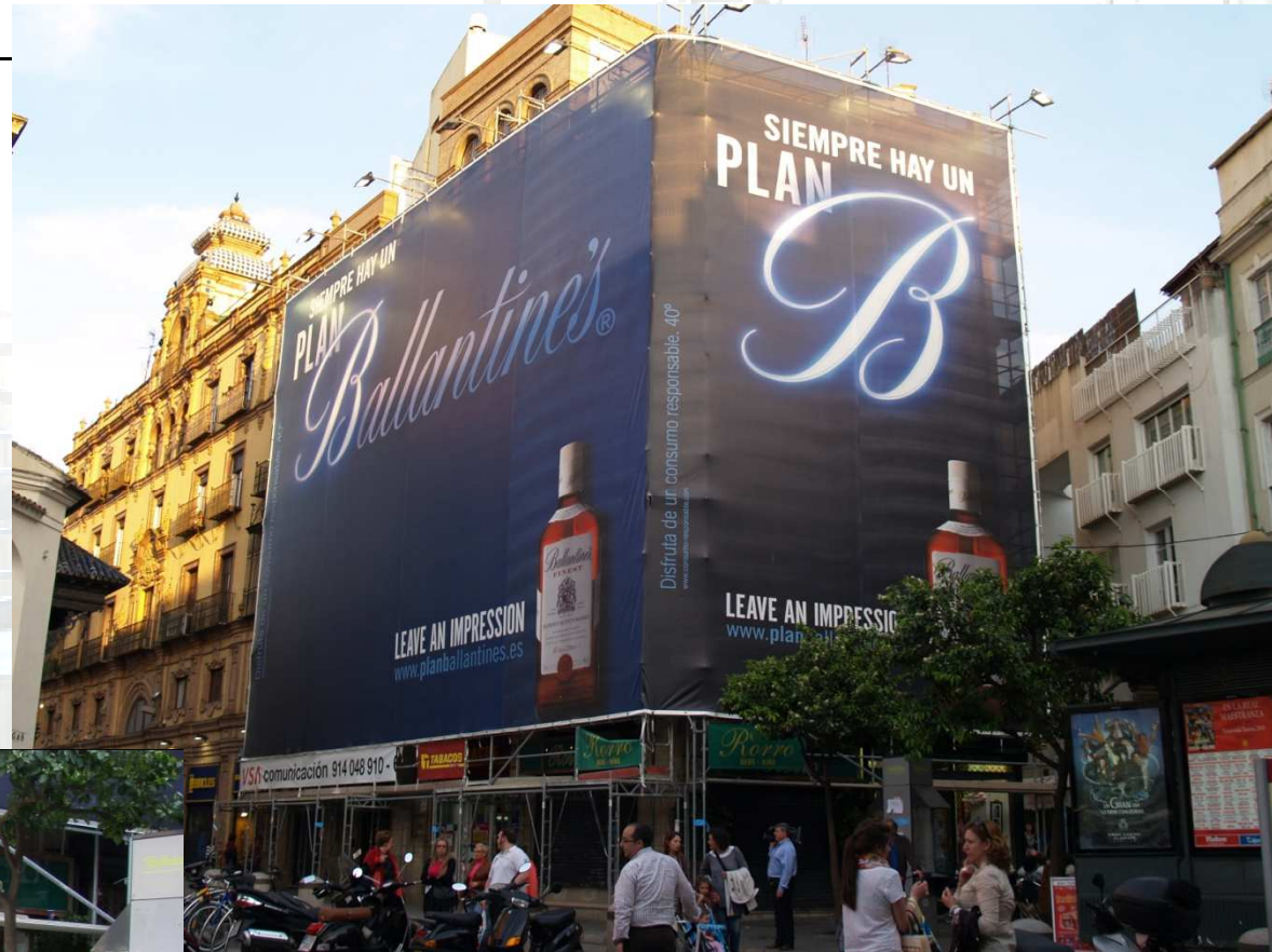
Calle Villegas-Plaza del Salvador (Sevilla) Detalle de base de paso y adaptación del andamio para dejar escaparate de comercio libre
