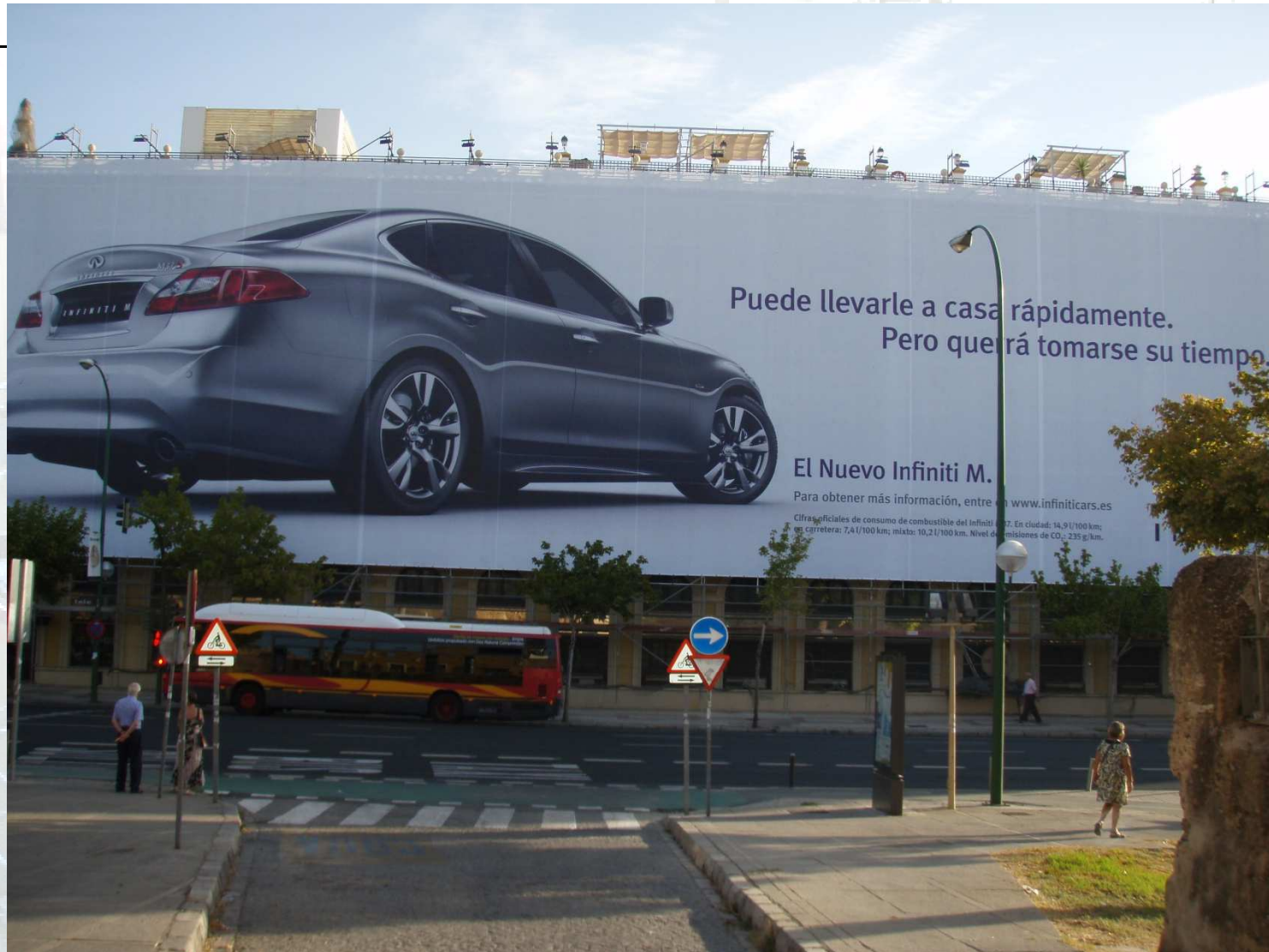
Hotel Macarena (Sevilla) Andamio para lona de grandes dimensiones.
