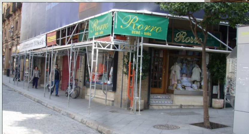
Calle Villegas-Plaza del Salvador (Sevilla) Detalle de base de paso y adaptación del andamio para dejar escaparate de comercio libre
