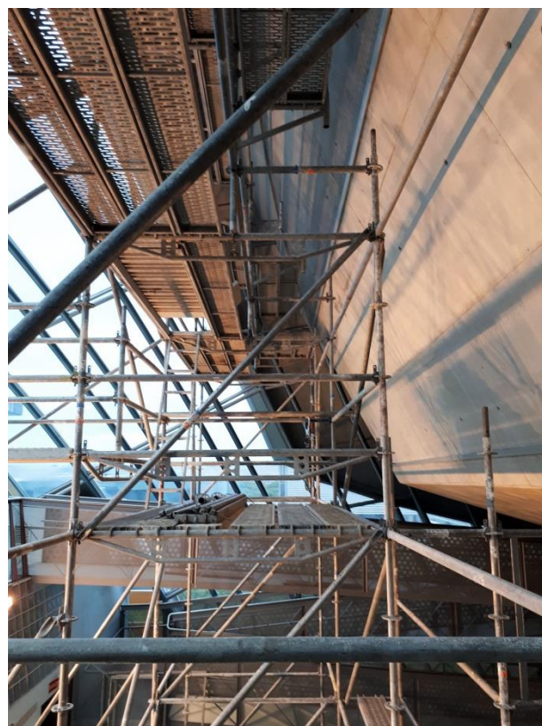
Estructura multidireccional para trabajos sobre bóveda y lucernario tanto por el interior como por el exterior del edificio.
