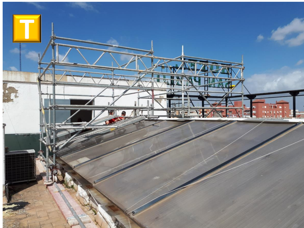
Estructura móvil sobre rail adaptada a las pendientes de los lucernarios para la sustitución de las placas de metacrilato
