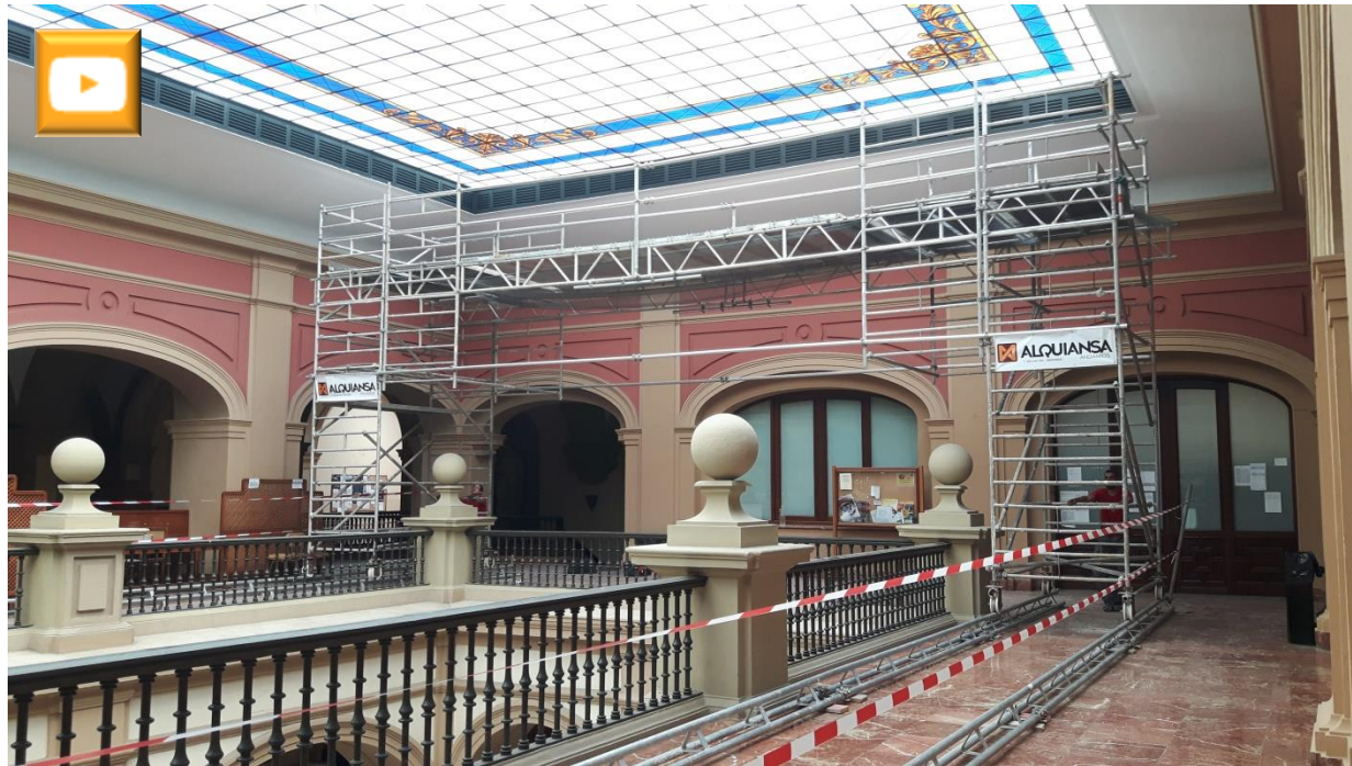
Rectorado de Sevilla (Real Fábrica de Tabacos) estructura móvil sobre railes librando hueco de patio.
