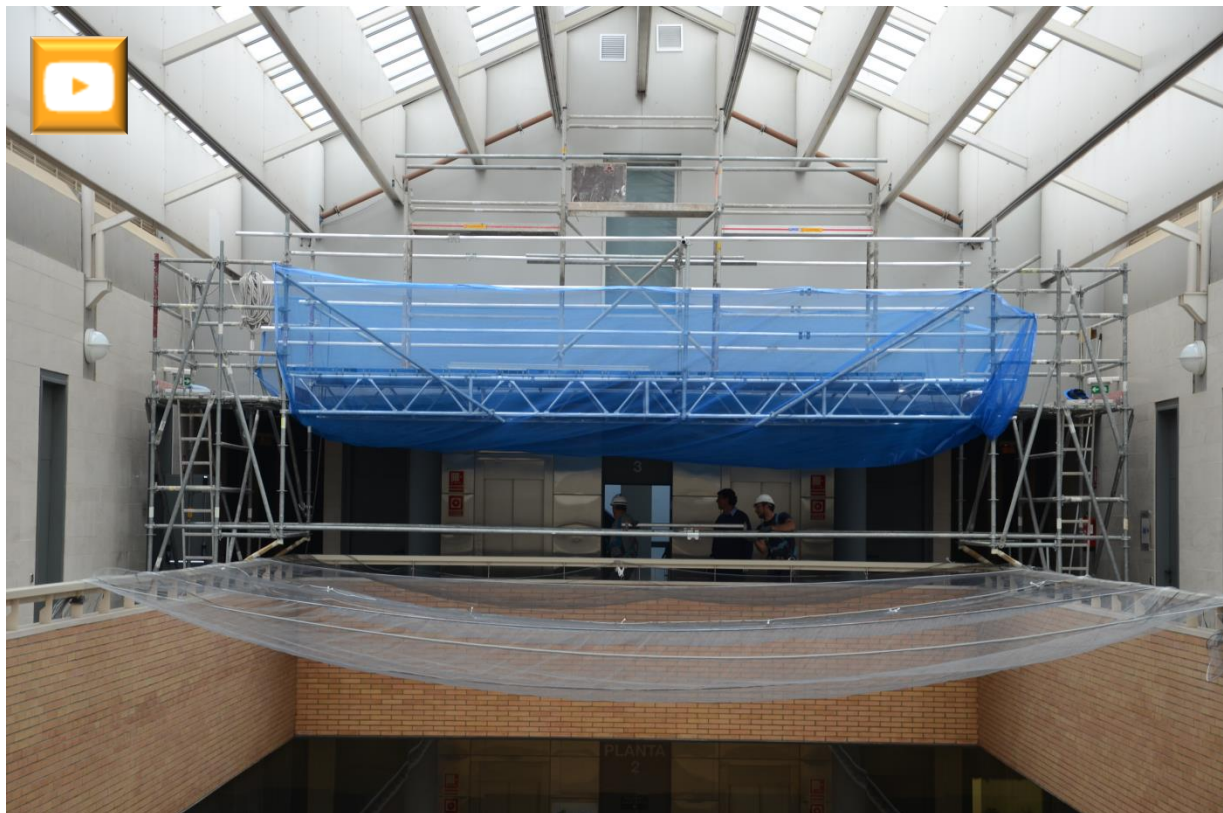
Edificio Realia (Sevilla) estructura móvil librando hueco de patio y adaptada a la pendiente a dos aguas de la cubierta.
