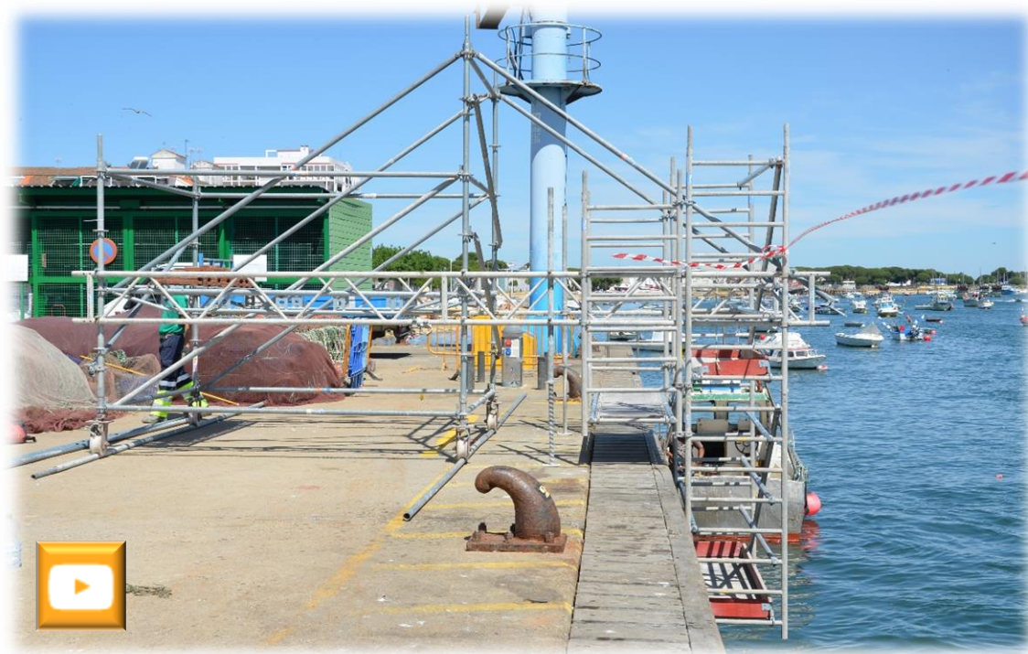
Pantalán de Punta Umbría , andamio para trabajar el frente en toda su longitud.
