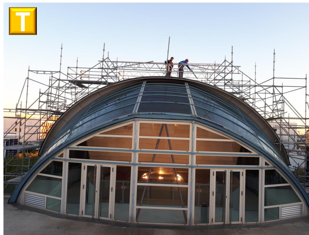
Estructura multidireccional para trabajos sobre bóveda y lucernario tanto por el interior como por el exterior del edificio.
