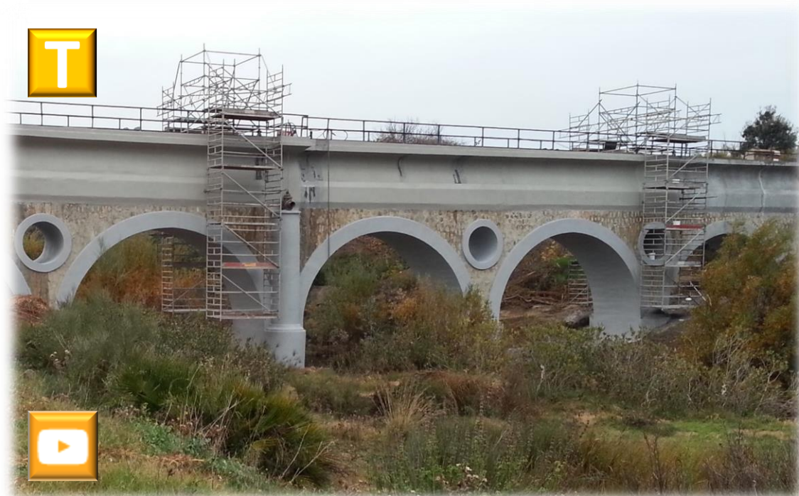
Acueductos del Viar (Cantillana) Torres para la reparación de los paramentos laterales y bajo de los arcos.
